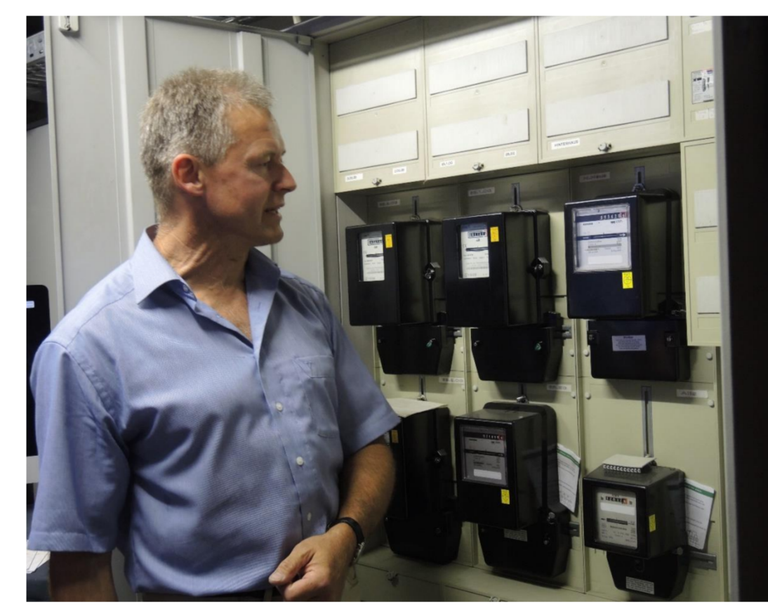
Wechselrichter einer PV-Anlage
